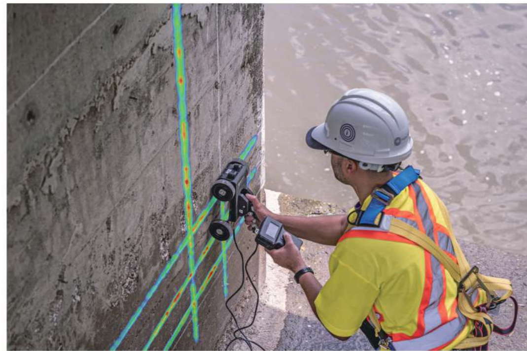
配筋探査の野書線上を iCAMM スキャナーで走査するだけ
