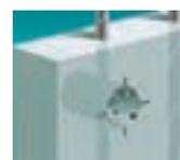
フェロスキャンで探査すれば切断・穴明け作業時の構造用鉄筋への干渉を確実に避けられます。
