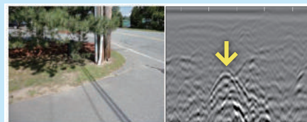
電柱から建物まで伸びる埋設管
